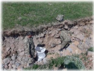
Kəlbəcər rayonu, təminat vollarının tikintisi
