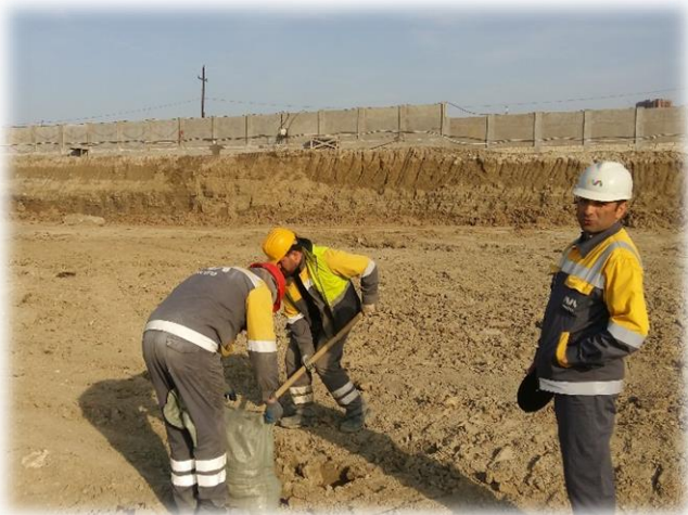
Bakı şəhəri, Həcəsən metrostansiyasının tikintisi
