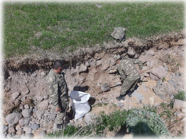
Kəlbəcər rayonu, təminat yollarının tikintisi
