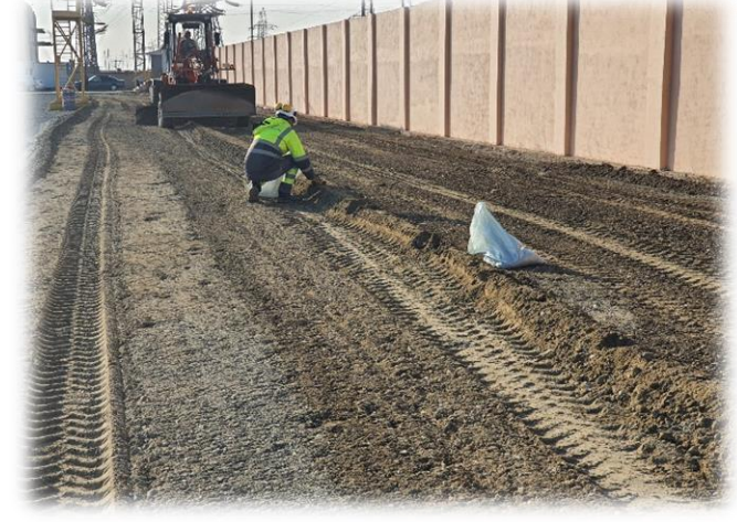
Holcim ASC-nin avtodayanacağıının tikintisi
